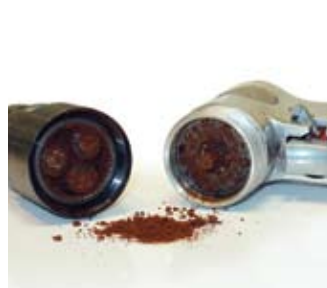
Вышедшая из строя пневматическая арматура
